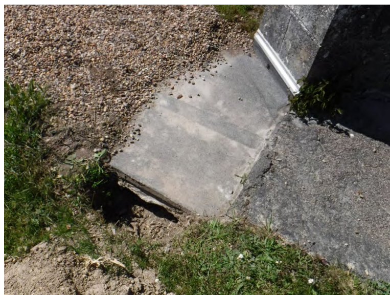
Photo 4. Sondage sur le bandeau en béton auprès du mur oriental. Photo Jakub Kurkiewicz, mai 2019
